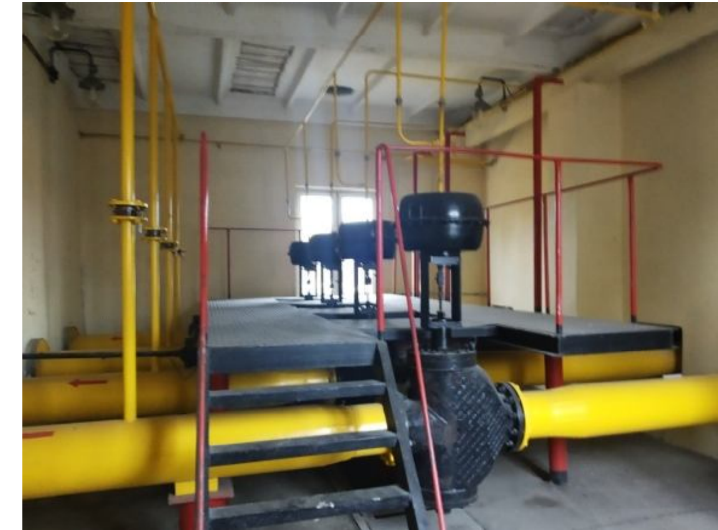
Технологічні лінії РП-2 з регуляторами тиску МТР
