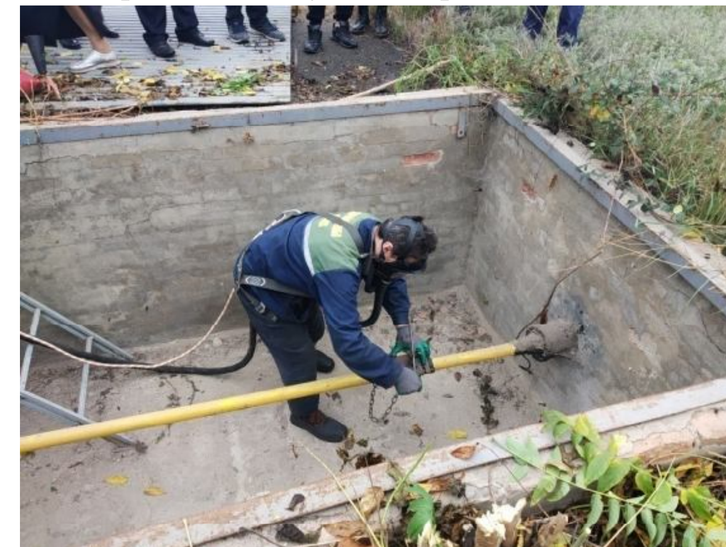
Установка датчикового хомута в місці
