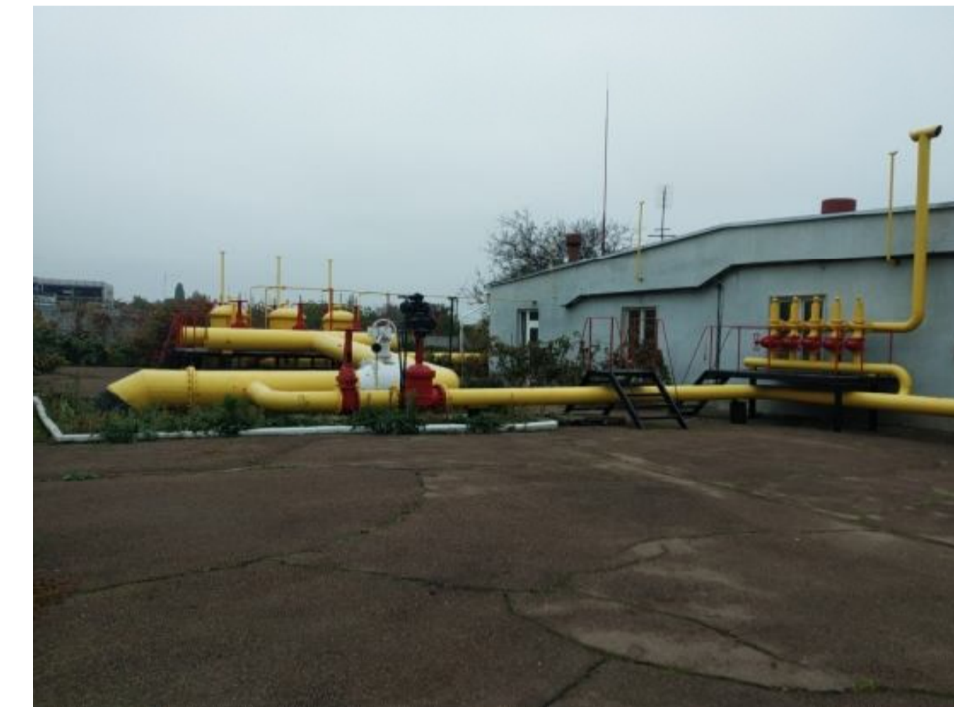
Система контролю тиску газу
