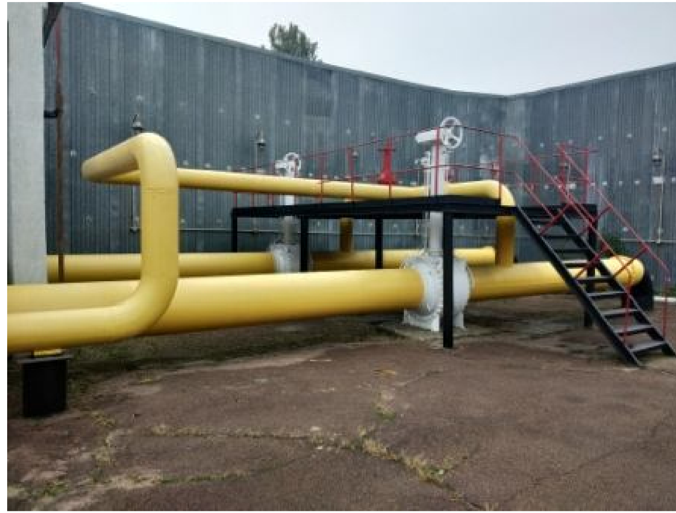
Основна лінія подачі газу середнього тиску в історичну частину м. Одеси
