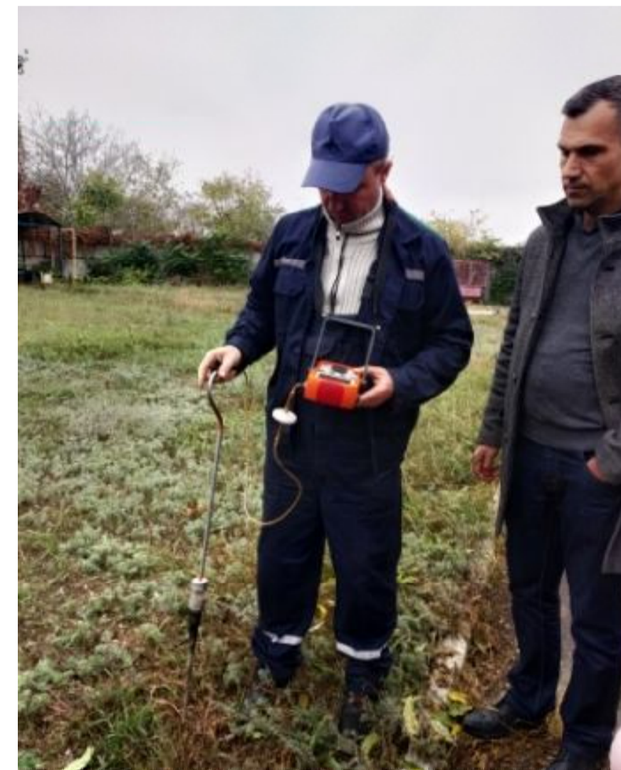
Пошук витоків газу на підземному газопроводі низького тиску за допомогою газоіндикатора фірми "Sewerin", Німеччина
