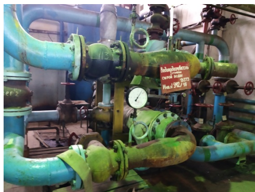
Насоси сирої води та їхня обв'язка
