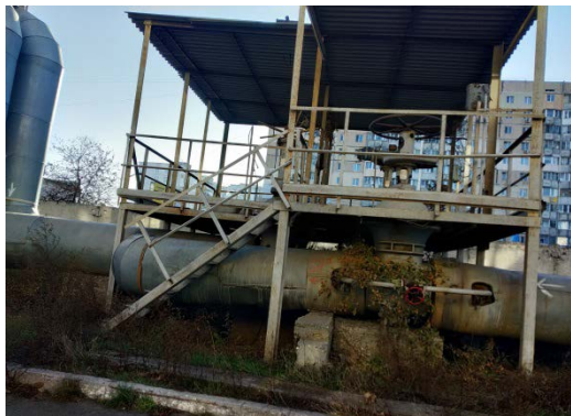
Засувки вихідні прямого та зворотного напрямків (вул. Дніпровська та пр. Добровольського)
